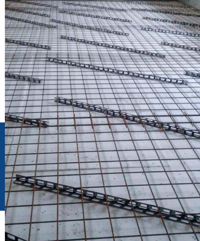
Rakennustyöt Ville Kauppi Oy testasi Porin Prikaatin kohteissaan uutta Pintos tankovälikettä.
