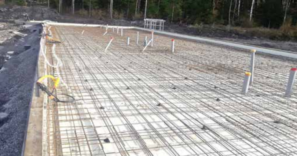
Kaistaraudoite-asennus Kaarinan Eerolankadun rivitalokohteessa.
